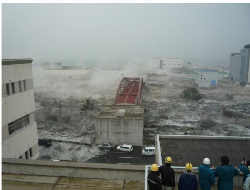
2011年3月11日 津波の被災を受ける南蒲下水道処理場 出典:仙台市ホームページ
